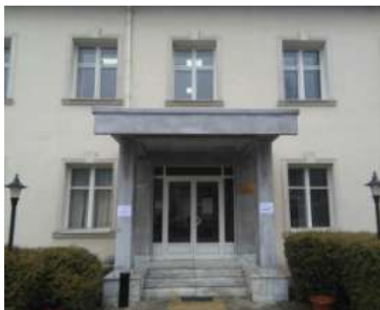
Zgrada odeljenja u Guči
