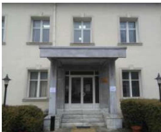
Zgrada odeljenja u Guči
